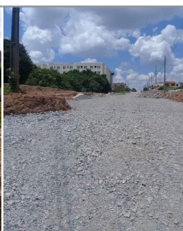
Figura 2 – Parte da rua em processo de asfaltamento
